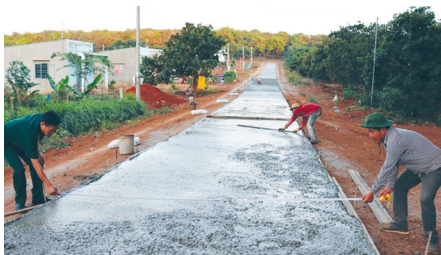
Xây dựng đường giao thông nông thôn trên địa bàn huyện Bù Gia Mập. Ảnh: TL
