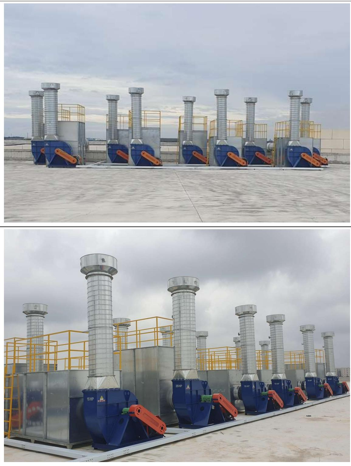
Hình 3.21 - Một số hình ảnh hệ thống xử lý bụi sơn và hơi dung môi
