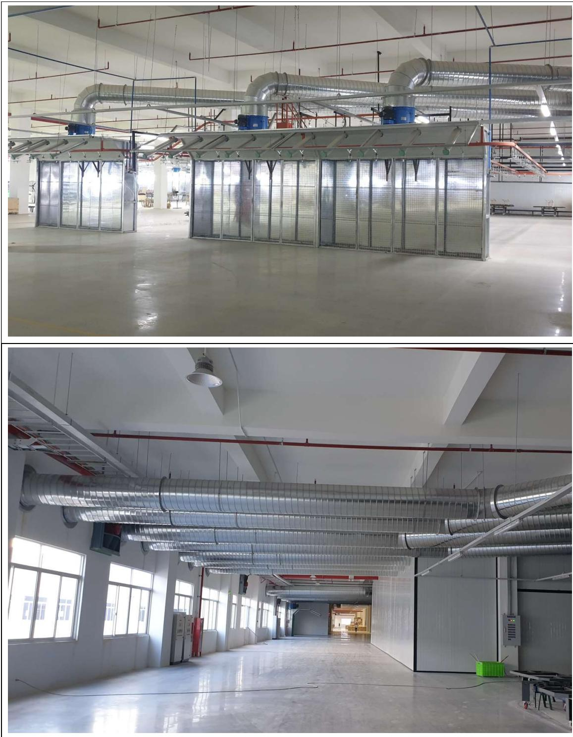
Hình 3.20 - Hình ảnh hệ thống thu gom bụi sơn và hơi dung môi
