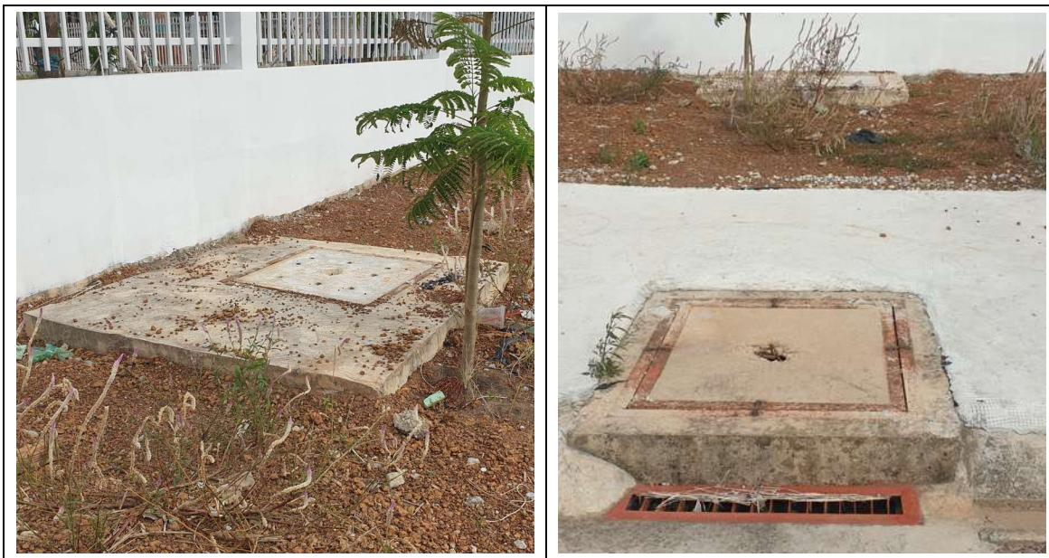
Hình 3.3 - Hô ga thu gom nước mưa từ các nhà xưởng trước khi xả ra cống thoát nước mưa chung của Khu công nghiệp Đồng Xoài III
