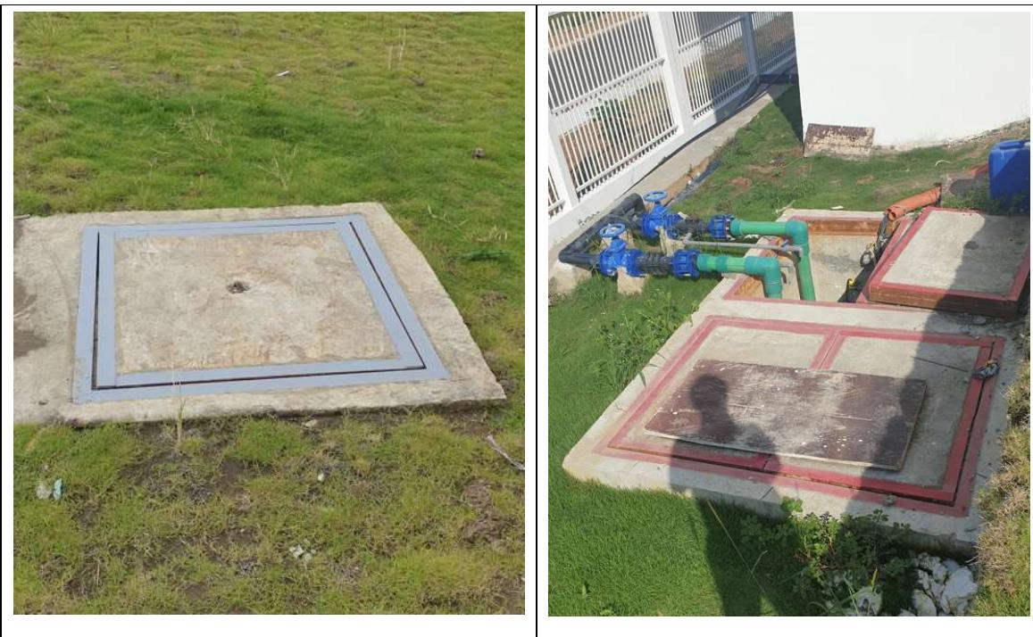
Hình 3.7 - Hồ ga thu gom và thoát nước thải của cơ sở
