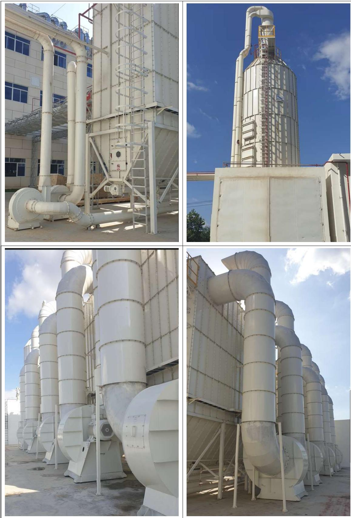
Hình 3.17 - Một số hình ảnh hệ thống xử lý bụi của nhà máy
