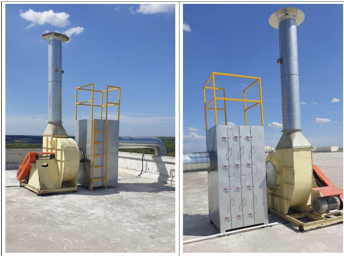
Hình 3.26 - Một số hình ảnh hệ thống xử lý hơi keo của nhà máy
