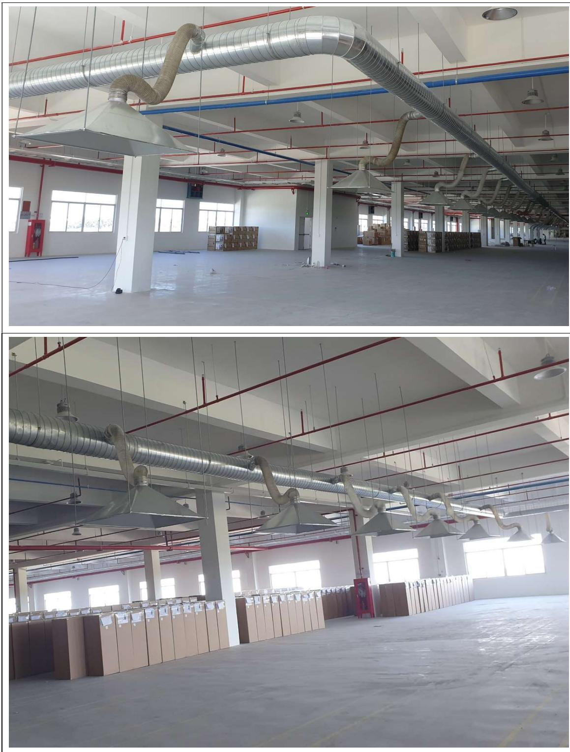
Hình 3.25 - Một số hình ảnh hệ thống thu gom hơi keo của nhà máy
