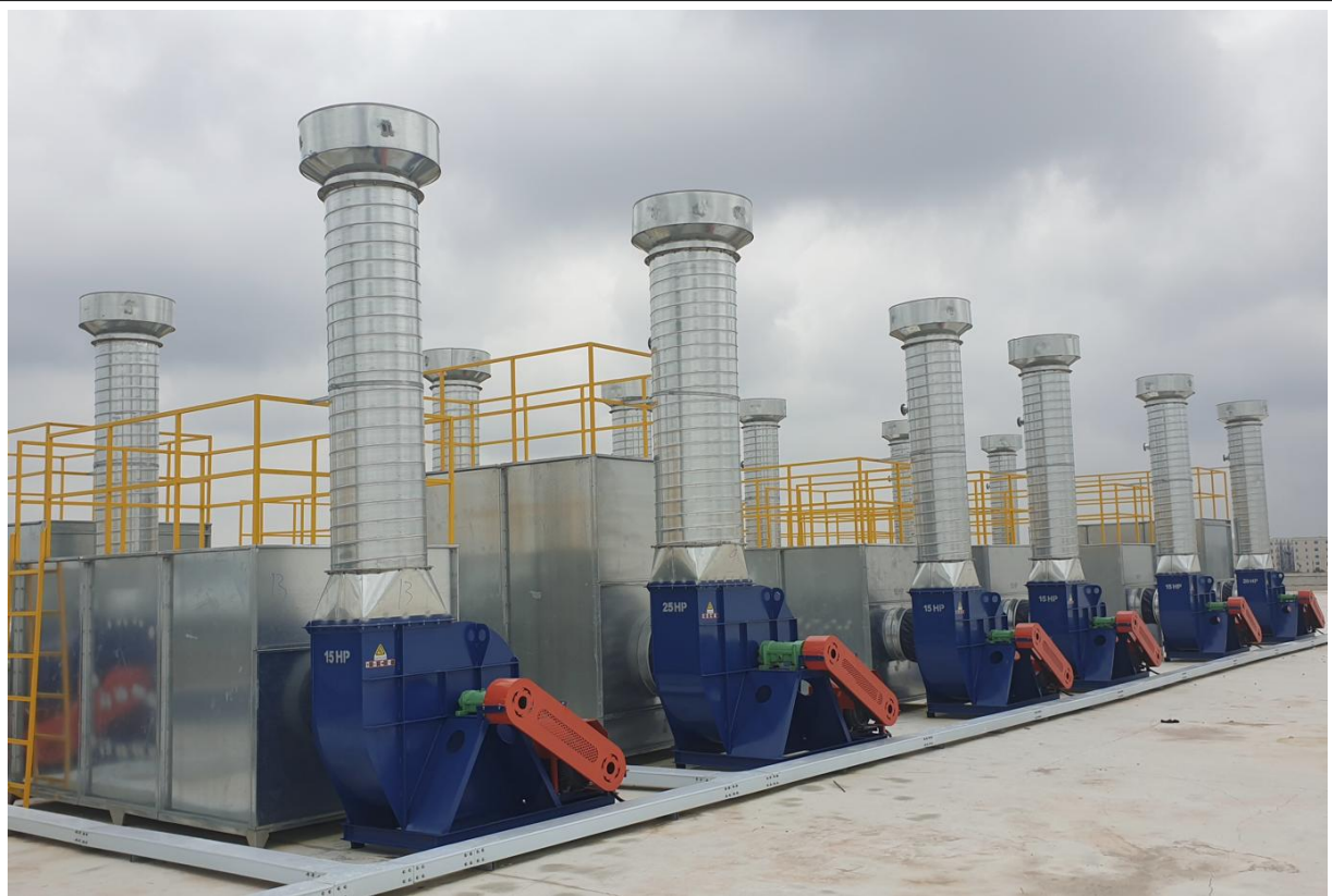
Hình 3.21 - Một số hình ảnh hệ thống xử lý bụi sơn và hơi dung môi
