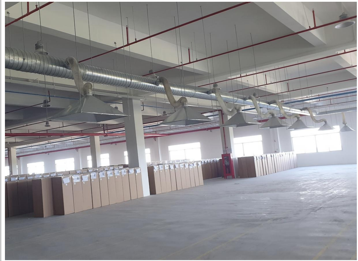
Hình 3.25 - Một số hình ảnh hệ thống thu gom hơi keo của nhà máy
