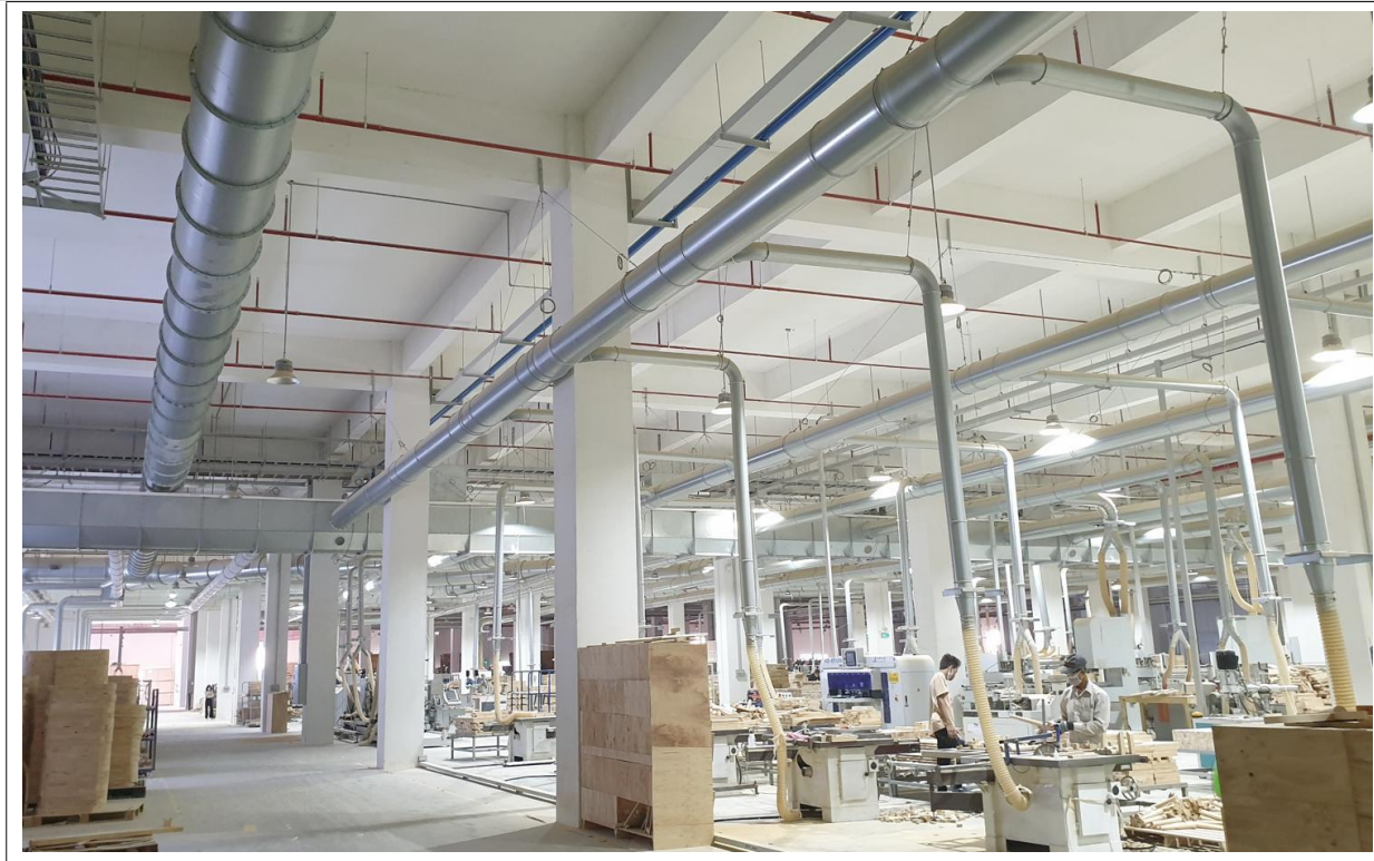
Hình 3.16 - Một số hình ảnh hệ thống thu gom bụi của nhà máy
