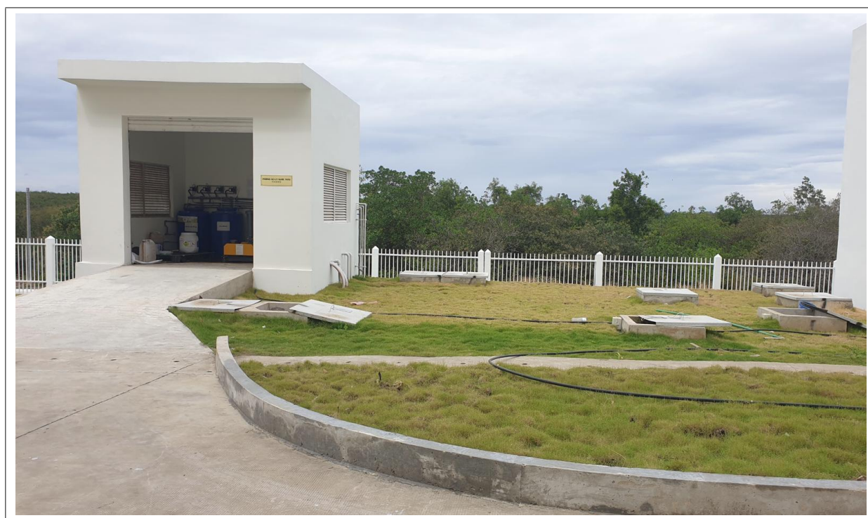
Hình 3.11 - Khu vực công trình hệ thống xử lý nước thải của nhà máy
