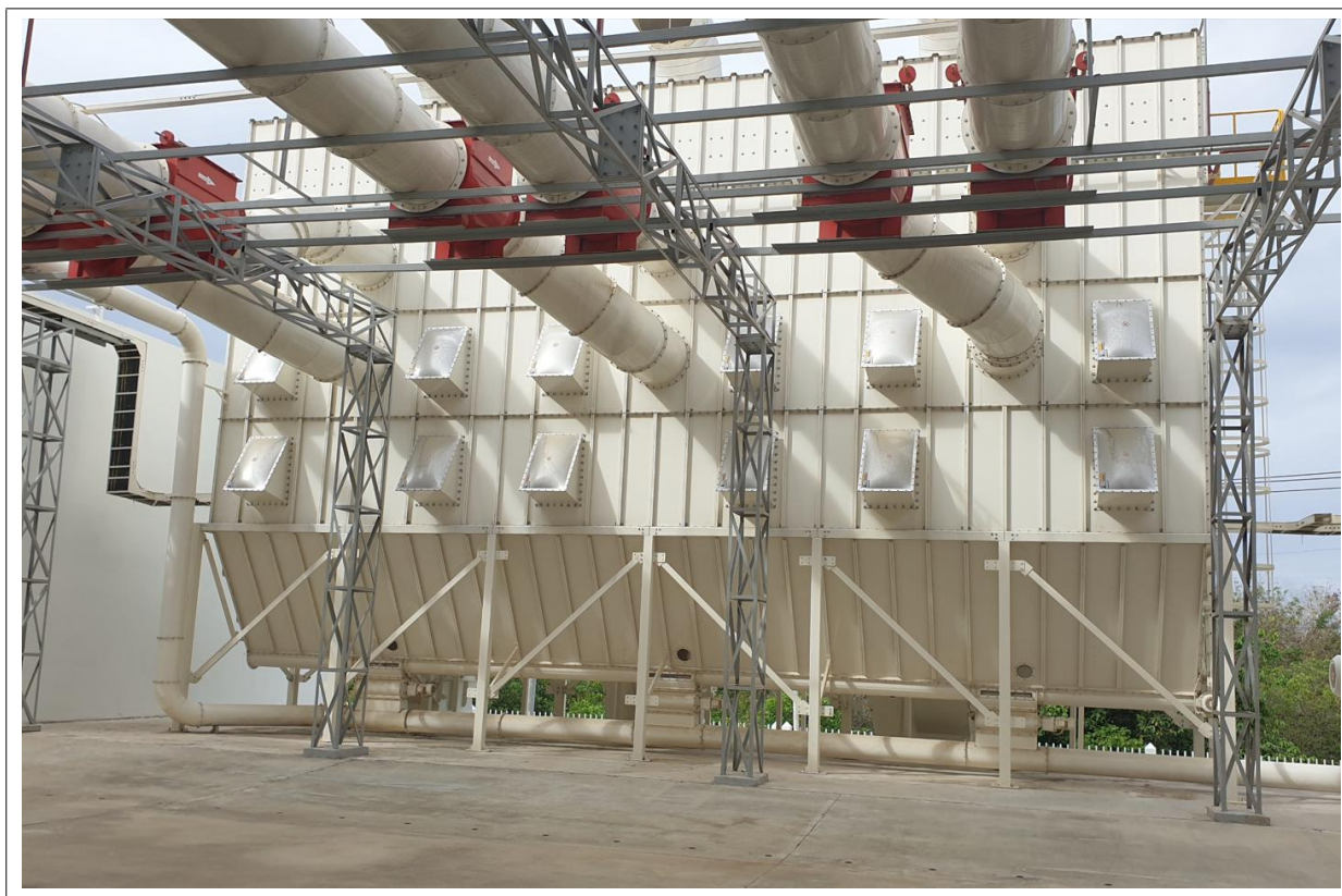
Hình 3.16 - Một số hình ảnh hệ thống thu gom bụi của nhà máy
