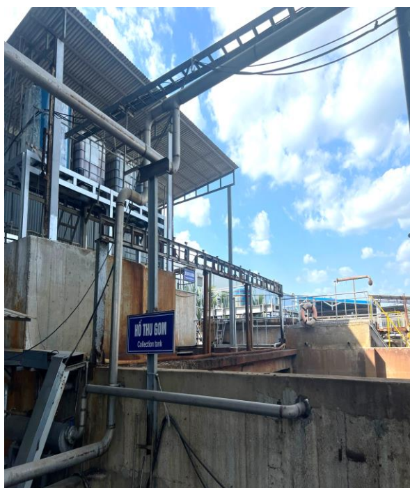
Bể thu gom
