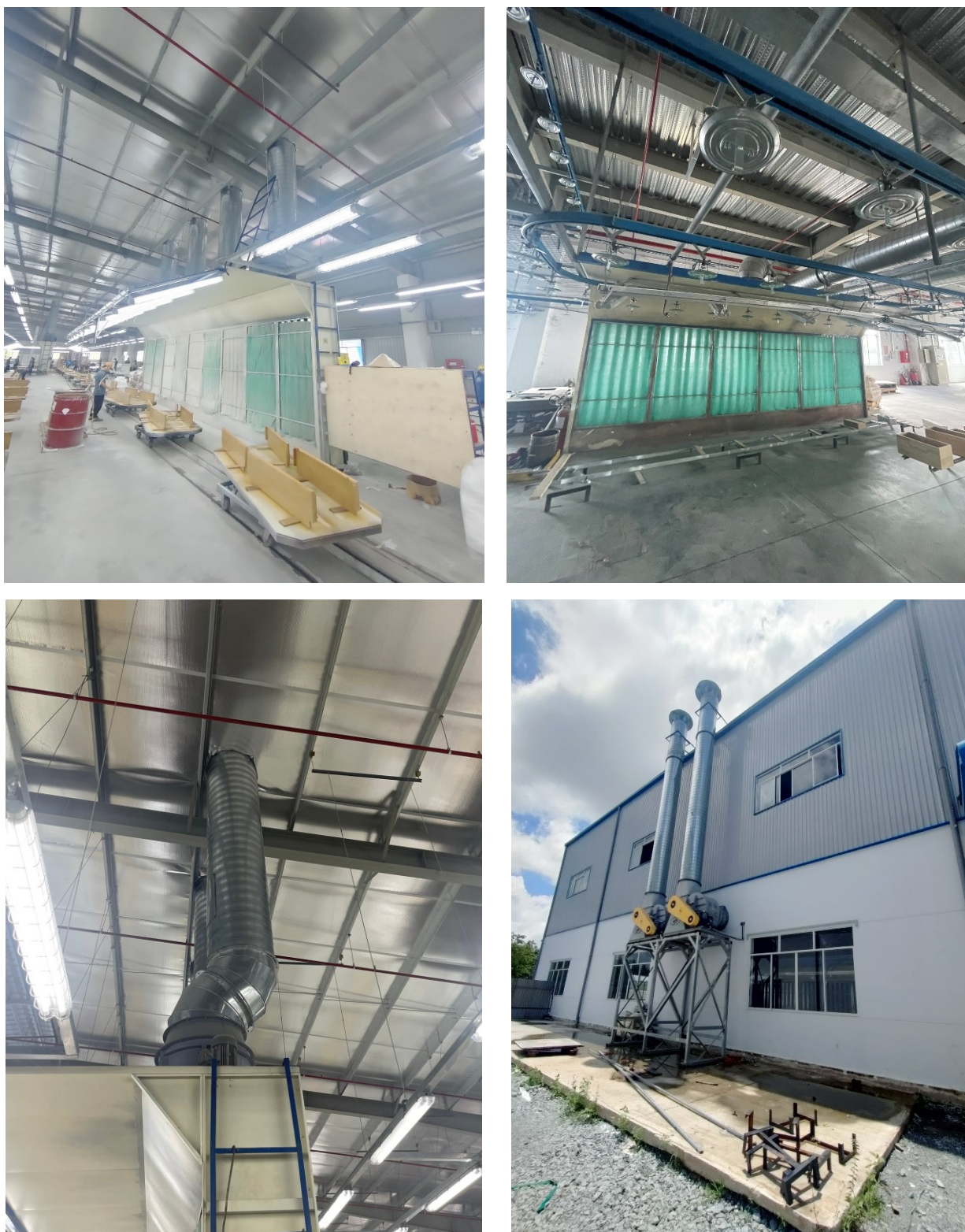
Hình 4.9 Hệ thống thu gom và xử lý bụi ở khu vực sơn
