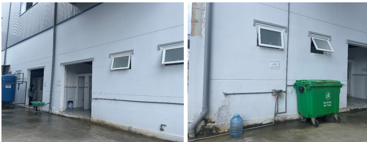
Hình 4.10 Nhà vệ sinh
