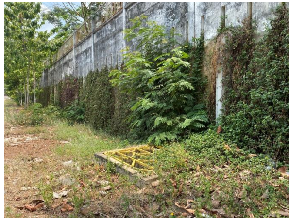
Hình 3. 5: Điểm đầu nối nước thải tại đường D3
