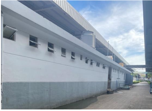
Hình 3. 9: Khu vực nhà vệ sinh
