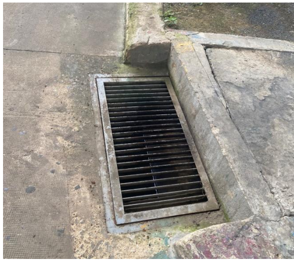
Hình 3. 1: Nắp hồ ga kết hợp song chắn rác thu gom nước mưa
