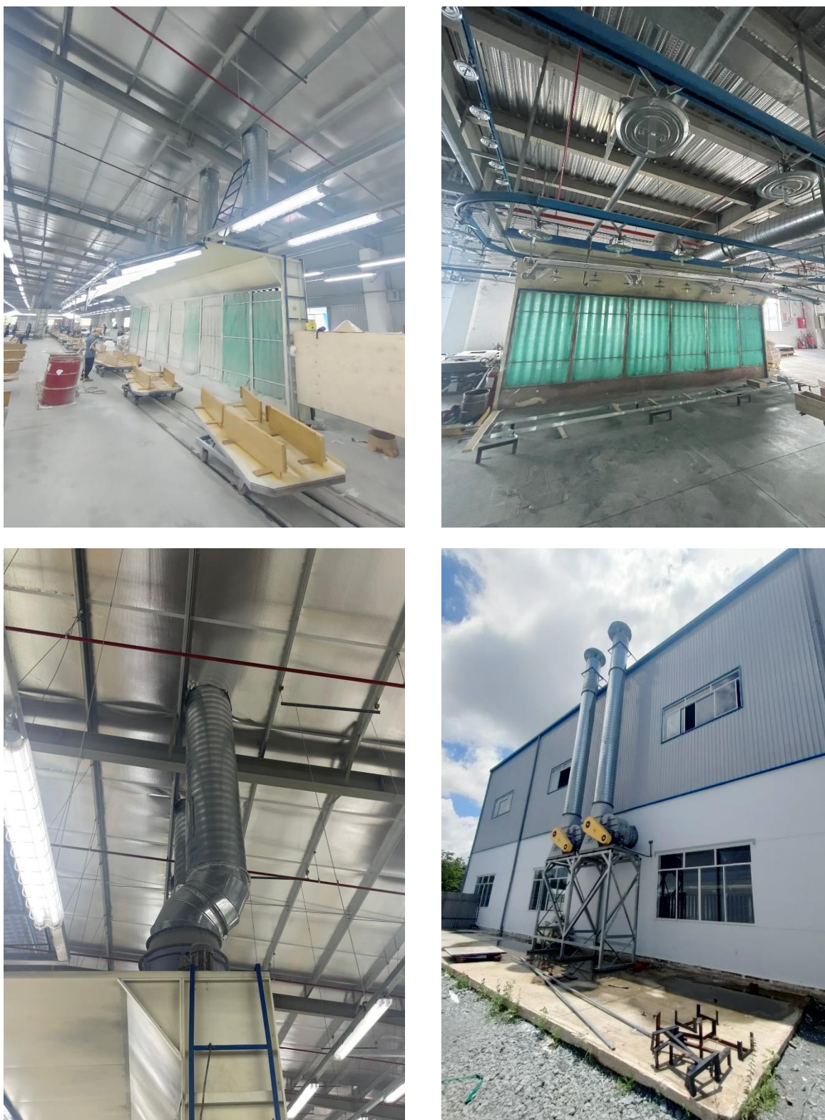
Hình 3.13 - Hệ thống thu gom và xử lý khí thải từ quá trình sơn
