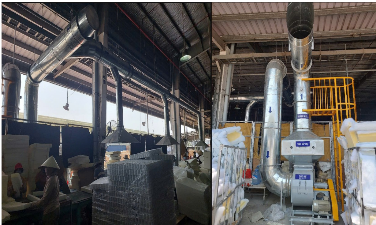
Hình 3. 8. Hình ảnh hệ thống xử lý hơi keo
