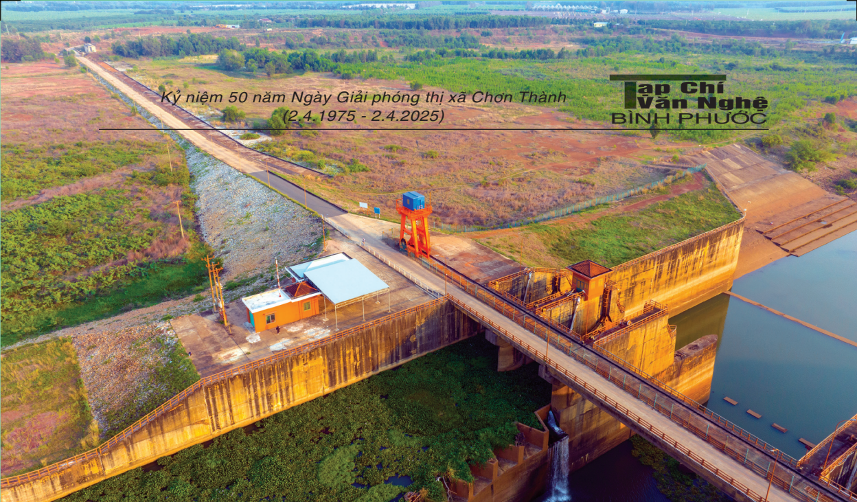
Một góc công trình thủy lợi Thị xã Chơn Thành.
