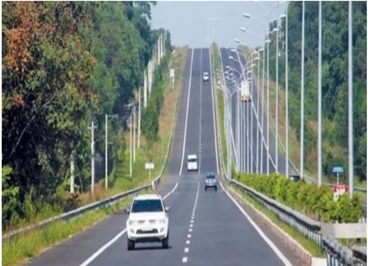
Hình 1.1. Hiện trạng tuyến đường giao thông đoạn vào khu vực dự án
