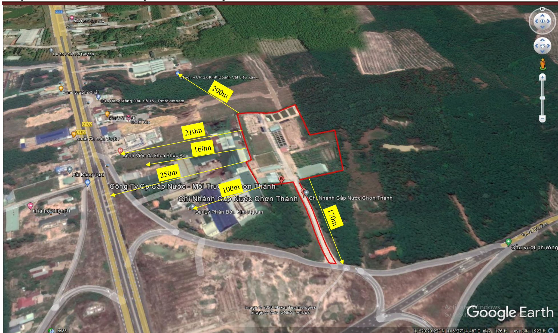
Hình 1.1. Vị trí nhà máy nước tại thị xã Chơn Thành đã đi vào hoạt động từ năm 2016 trên Googlemap
