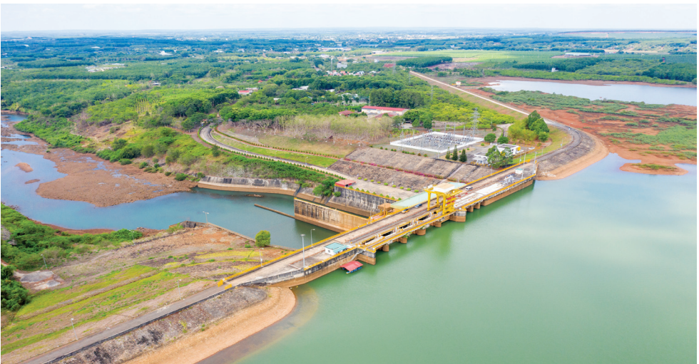
Toàn cảnh Nhà máy Thủy điện Cần Đơn.
