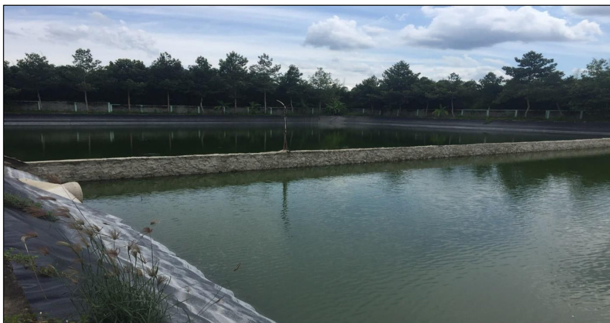
Hình 3-8: Hồ sự cố hệ thống xử lý nước thải
