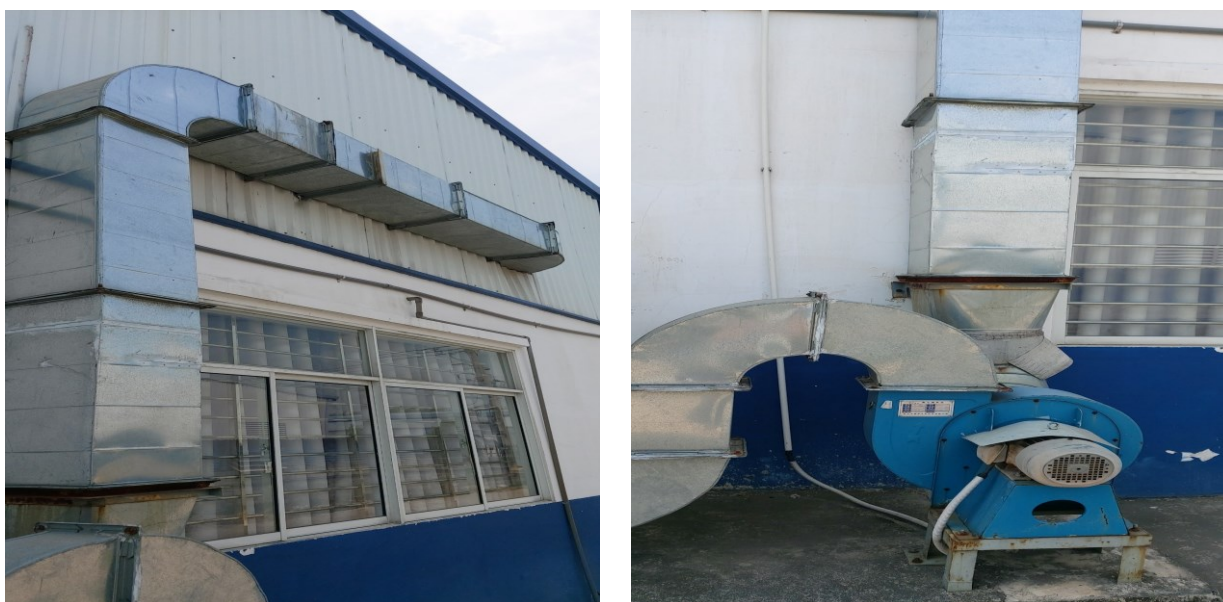
Hình 3.9. Hình ảnh hệ thống xử lý khí thải hơi dung môi công đoạn hàn thiếc
