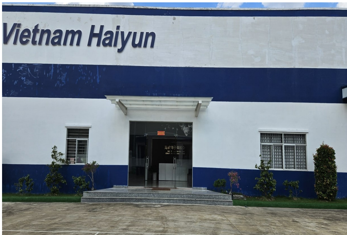
Hình 1.4. Nhà xưởng sản xuất
