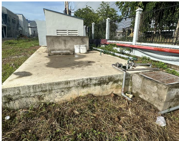
Trạm xử lý nước thải hiện hữu
