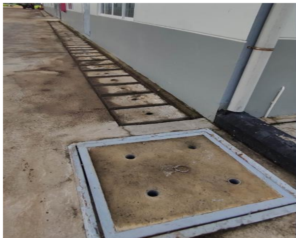
Hình 3.1. Hệ thống mương, hố ga thu gom nước mưa hiện hữu
