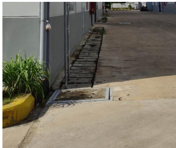
Hình 3.1. Hệ thống mương, hố ga thu gom nước mưa hiện hữu
