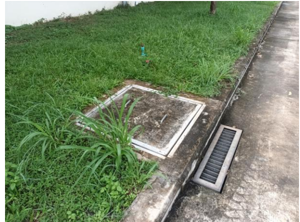
Hình 4.11. Hệ thống thu gom và thoát nước mưa hiện hữu tại Dự án
