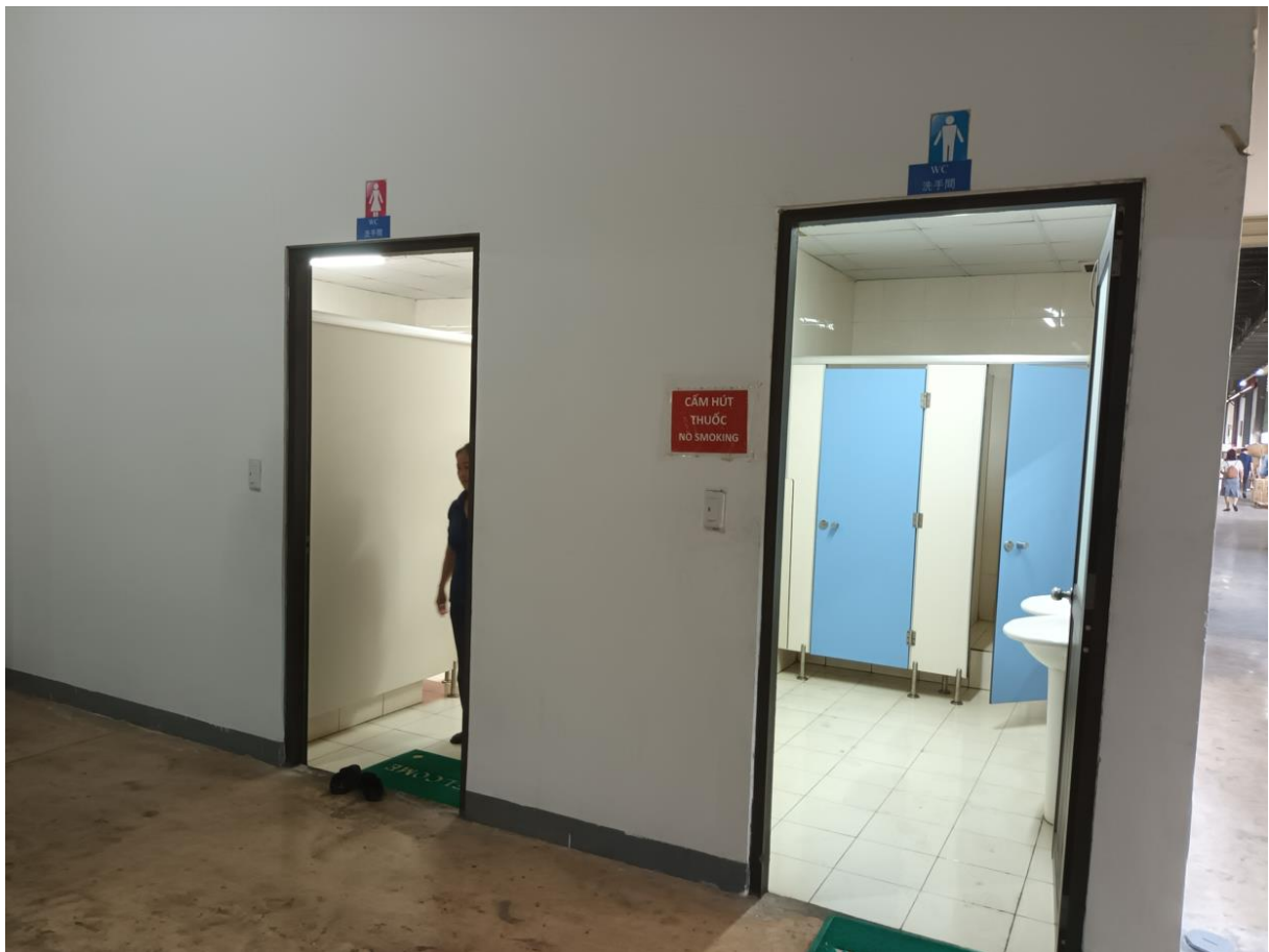
Hình 4.4. Khu nhà vệ sinh hiện hữu tại Dự án
