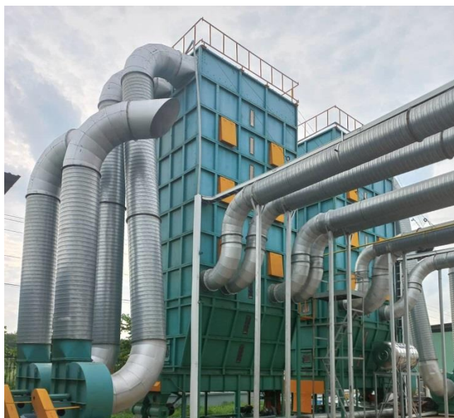
Hình 3. 9 Hệ thống xử lý khí thải công suất 6.000 m^3/h
