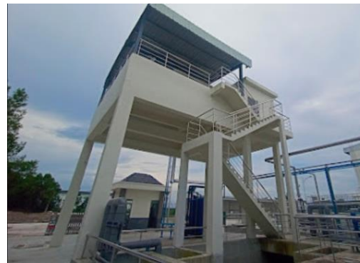
Nhà để máy ép bùn
