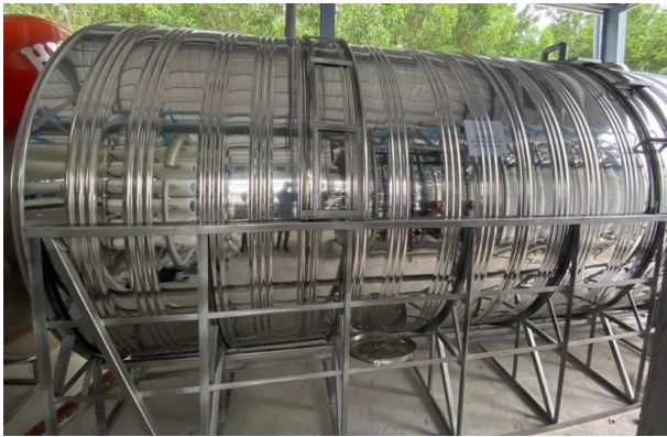
Bể chứa nước sau lọc RO
