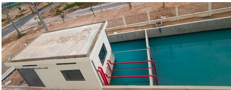
Nhà trạm bơm và bể chứa nước PCCC
