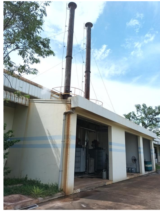
Hình 3.7. Lò hơi và hệ thống thoát khí thải
