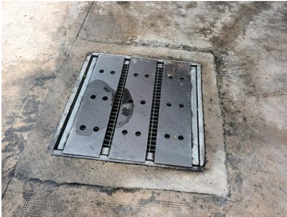
Hình 3.3. Hệ thống thu gom và thoát nước mưa hiện hữu tại Nhà máy
