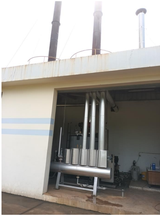
Hình 3.7. Lò hơi và hệ thống thoát khí thải
