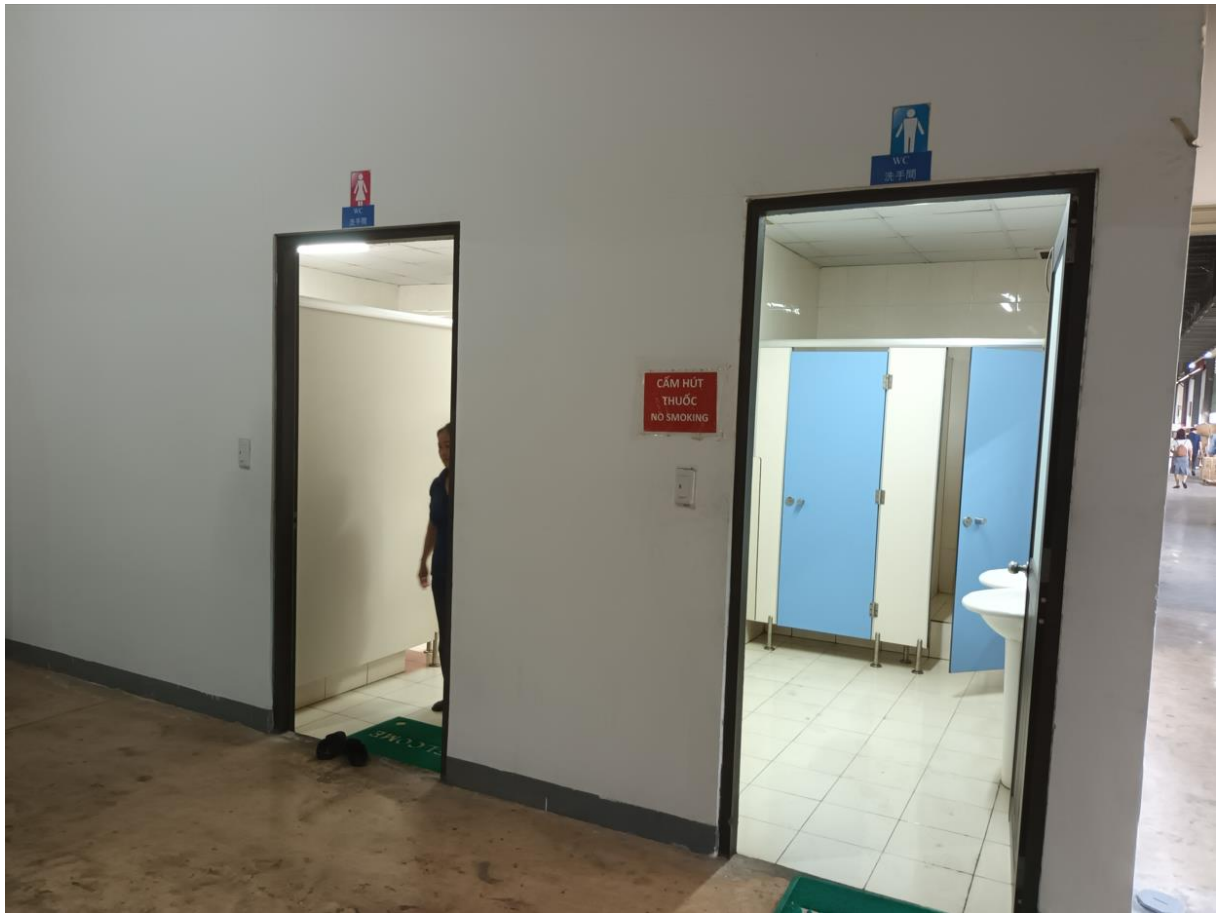
Hình 3.6. Khu nhà vệ sinh hiện hữu tại Dự án
