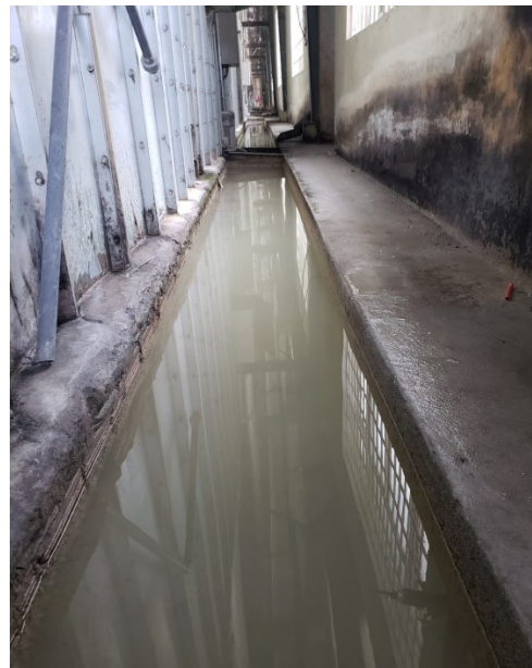
Hình 4.3. Buồng màng nước thu hồi bụi từ quá trình chà nhám thủ công
