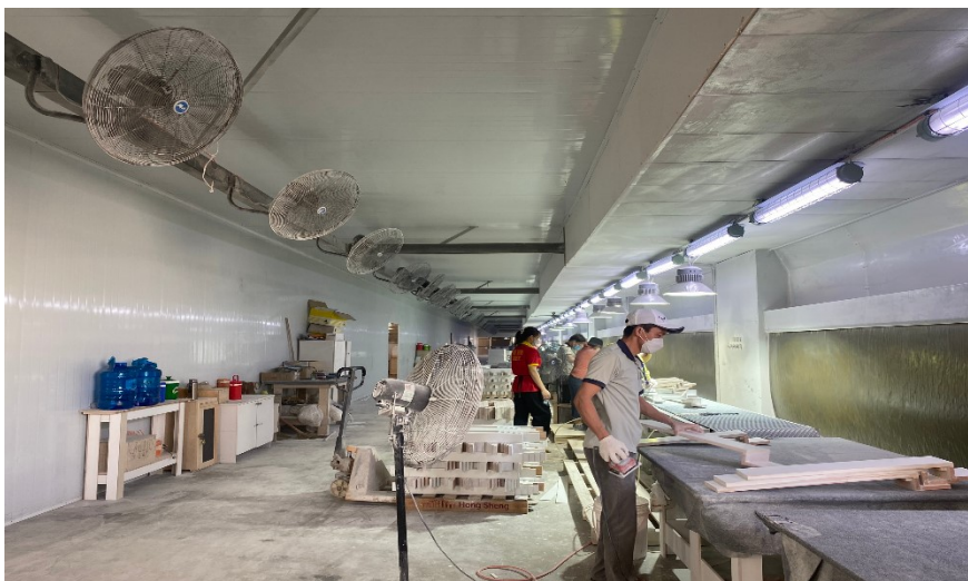
Hình 4.5. Bố trí quạt hút tạo lực trong quá trình chà nhám thủ công
