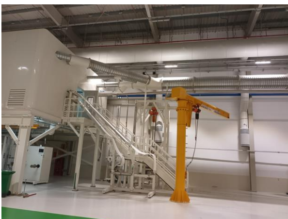
Hình 3.15. Hệ thống thu gom, xử lý bụi hiện hữu của dây chuyền sản xuất tơ quàn
