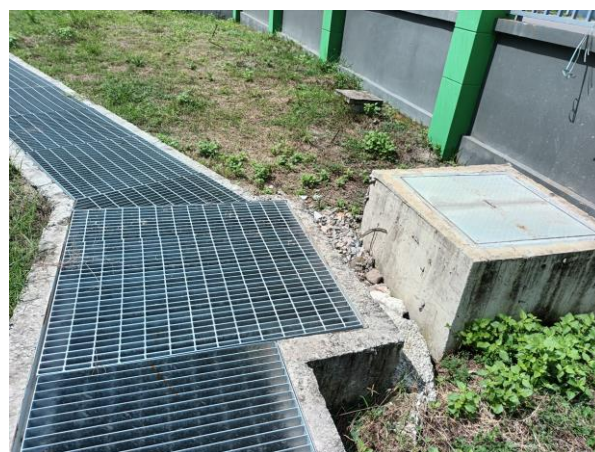
Hình 3.5. Hệ thống thu gom, thoát nước mưa và hồ ga đầu nổi nước mưa
