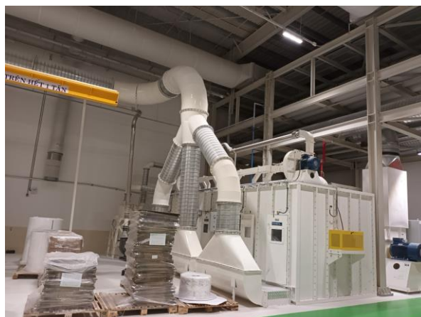
Hình 3.14. Hệ thống thu gom, xử lý bụi hiện hữu của dây chuyền sản xuất tơ dán
