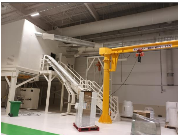
Hình 3.14. Hệ thống thu gom, xử lý bụi hiện hữu của dây chuyền sản xuất tơ dán
