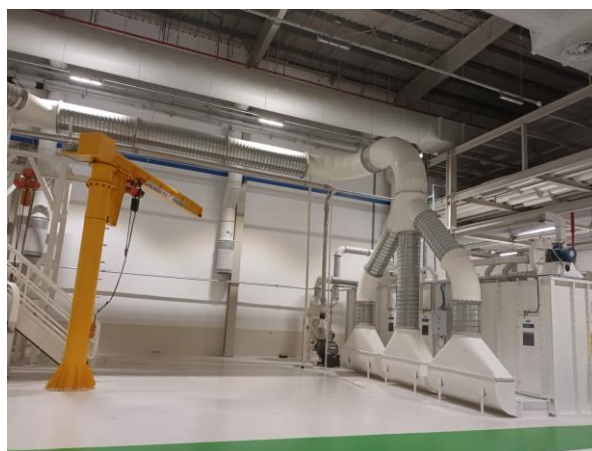
Hình 3.15. Hệ thống thu gom, xử lý bụi hiện hữu của dây chuyền sản xuất tơ quàn
