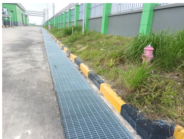
Hình 3.5. Hệ thống thu gom, thoát nước mưa và hồ ga đầu nổi nước mưa
