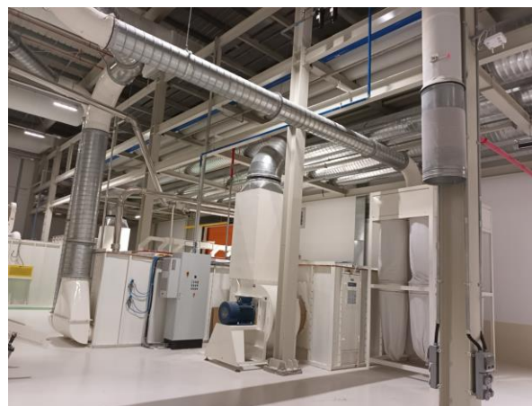
Hình 3.16. Hệ thống thu gom, xử lý bụi của dây chuyền sản xuất băng vệ sinh
