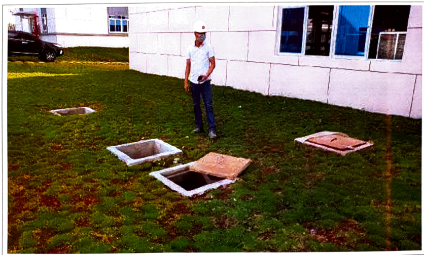
Hình 3.5 - Bể tách dầu mỡ tại nhà ăn của nhà máy
