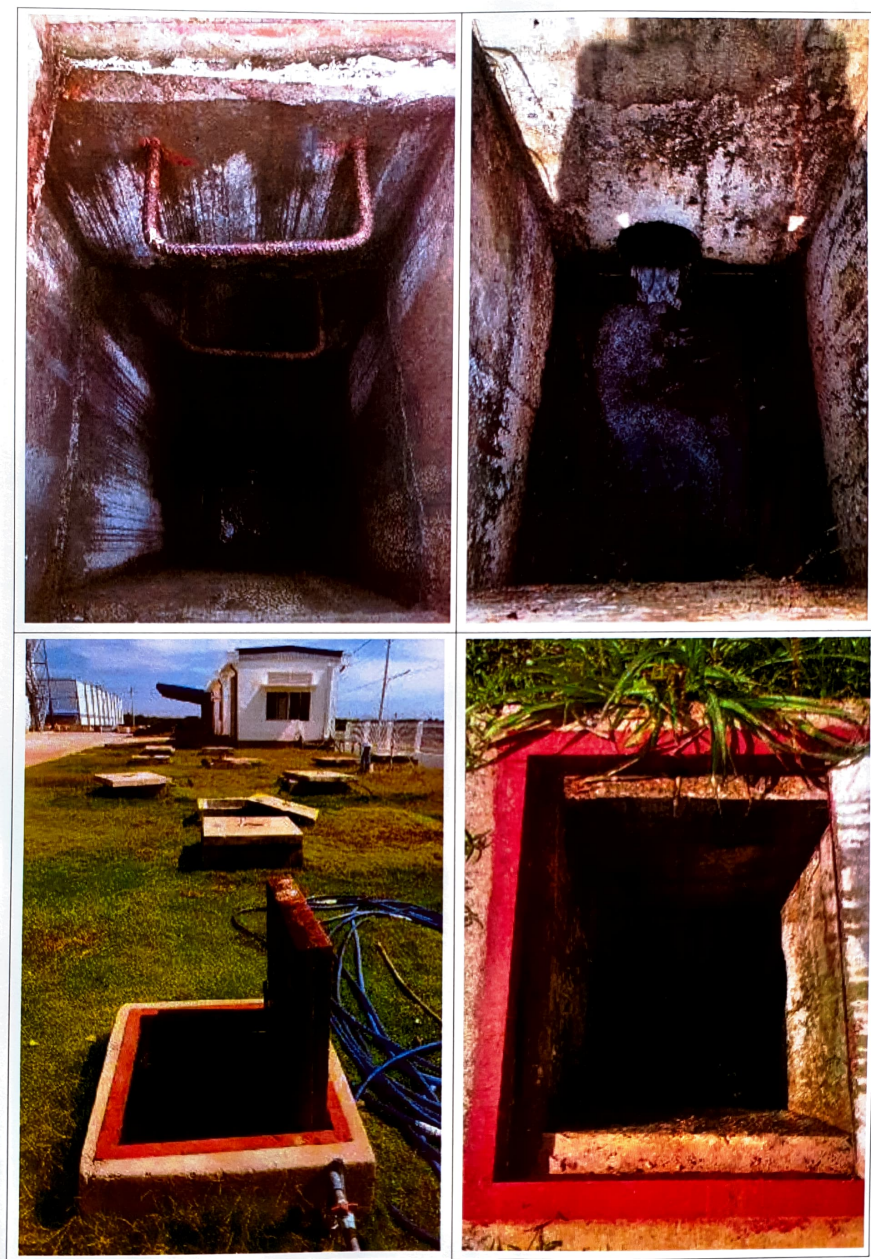
Hình 3.9 - Hồ ga thu gom nước thải của nhà máy
