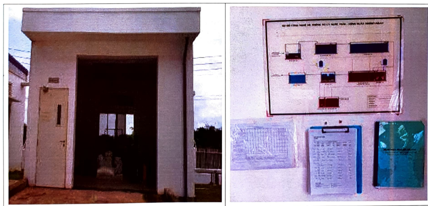
Hình 3.8 - Nhà điều hành xử lý nước thải của nhà máy
