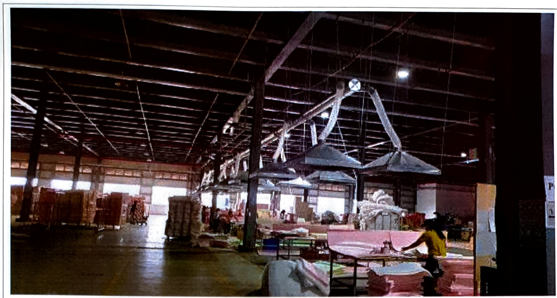
Hình 3.16 - Một số hình ảnh hệ thống thu gom hơi keo của nhà máy
