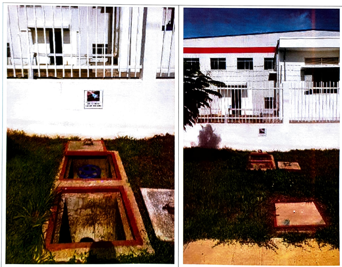
Hình 3.11 - Hố ga lấy mẫu giám sát nước thải sau xử lý
