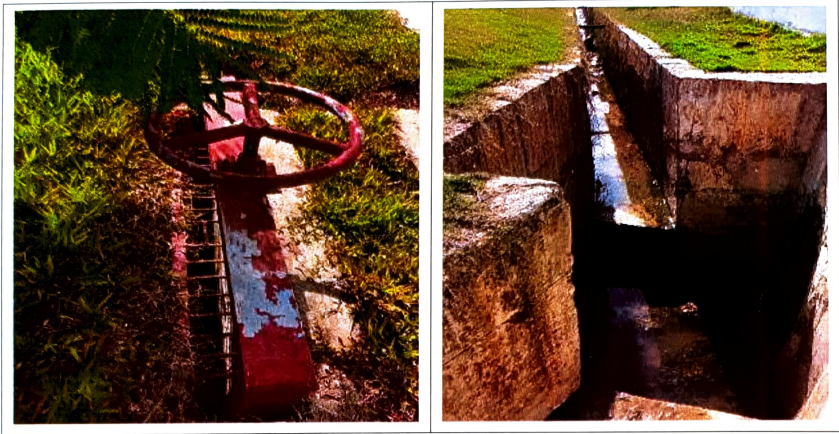
Hình 3.2 - Hồ ga thu gom nước mưa xung quanh các nhà xưởng
