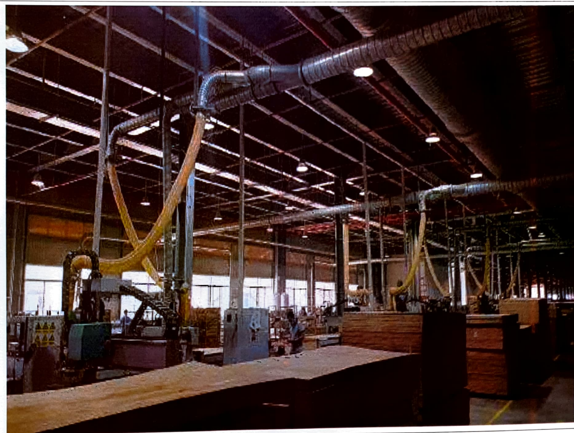
Hình 3.13 - Một số hình ảnh hệ thống thu gom bụi của nhà máy
