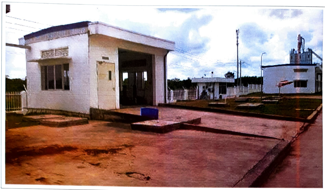
Hình 3.10 - Khu vực công trình hệ thống xử lý nước thải của nhà máy
